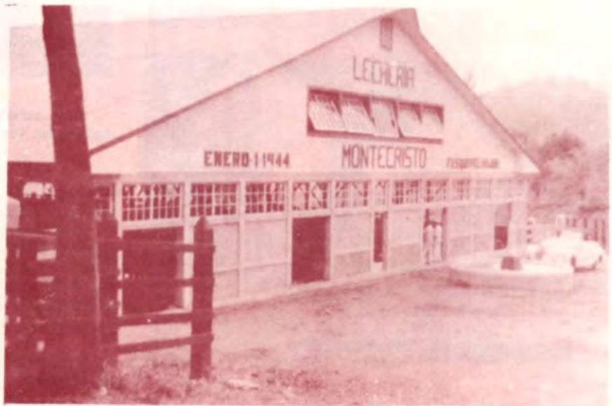
EL HERMOSO EDIFICIO DE LA LECHERIA
